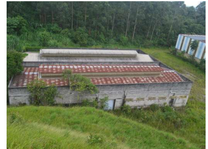
IMAGEM 12: Cobertura do Galpão Menor vista do talude. Foto: Renan Sampaio, 2019.
