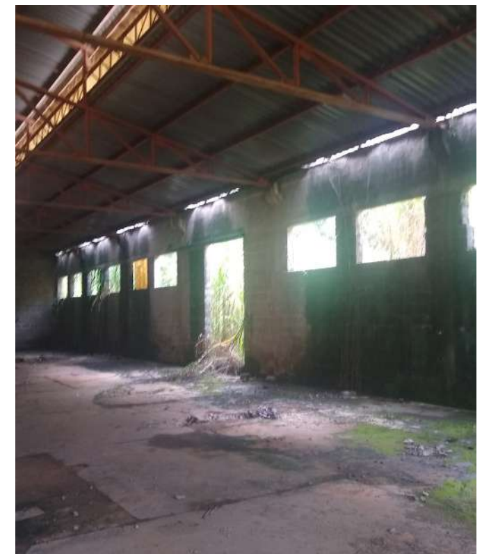
IMAGEM 15: Parede norte. Foto do Autor, 2019.
